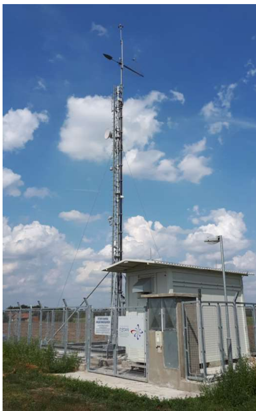
Slika 4.3 – Tipičan izgled DUKMS sa antenskim stubom tipa pauk (DUKMS Vincaid).
