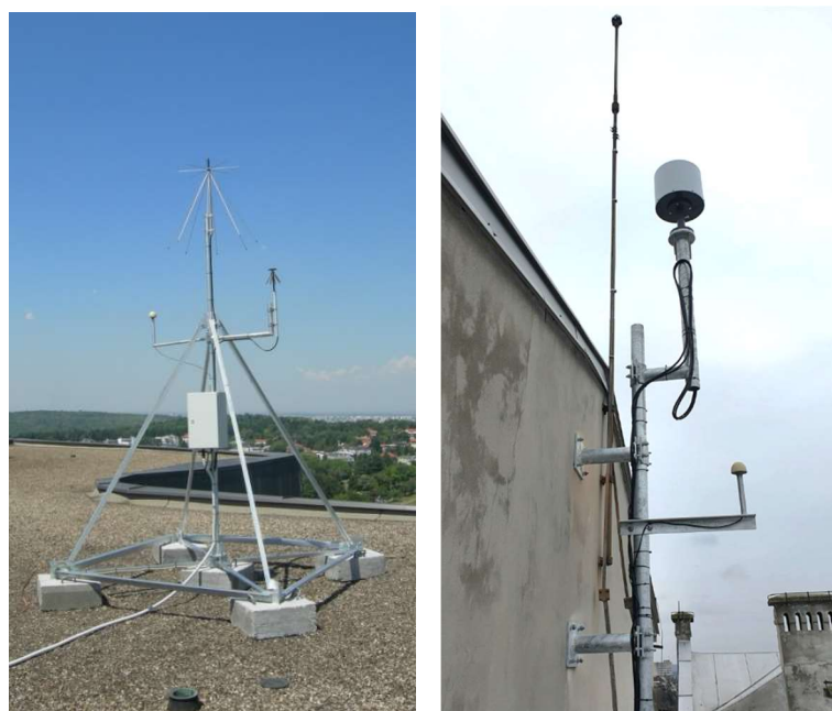
Slika 6.5 – Montaža KDUS na ravnom krovu objekta (levo) i bočno na zidu objekta (desno).
