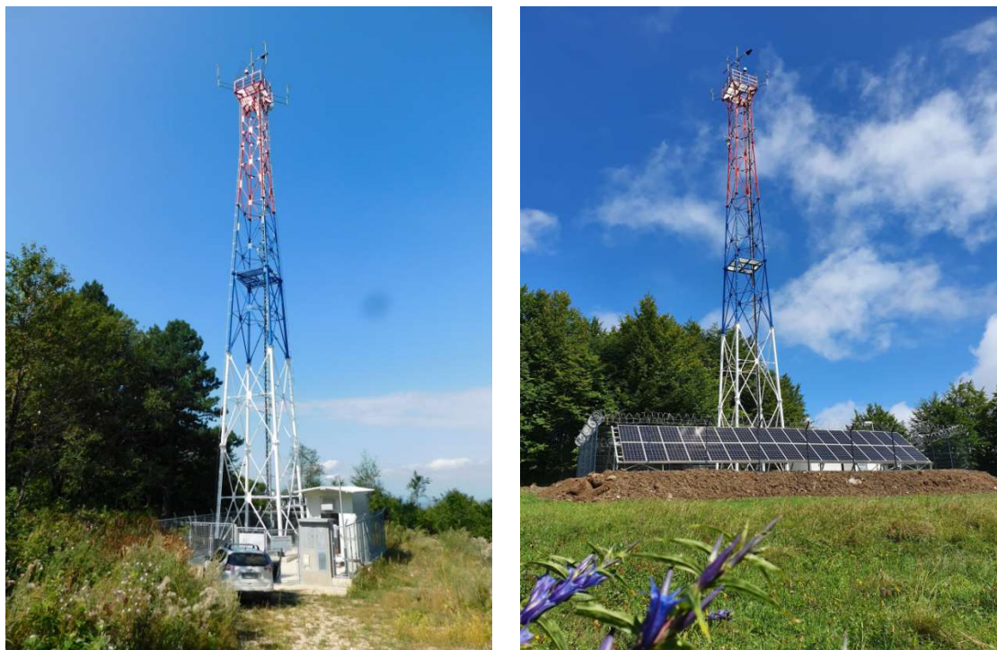
Slika 4.2 – Tipičan izgled DUKMS sa rešetkastim antenskim stubom bez (DUKMS Vidojevica) i sa (DUKMS Povlen) napajanjem realizovanim primenom solarnih panela.
